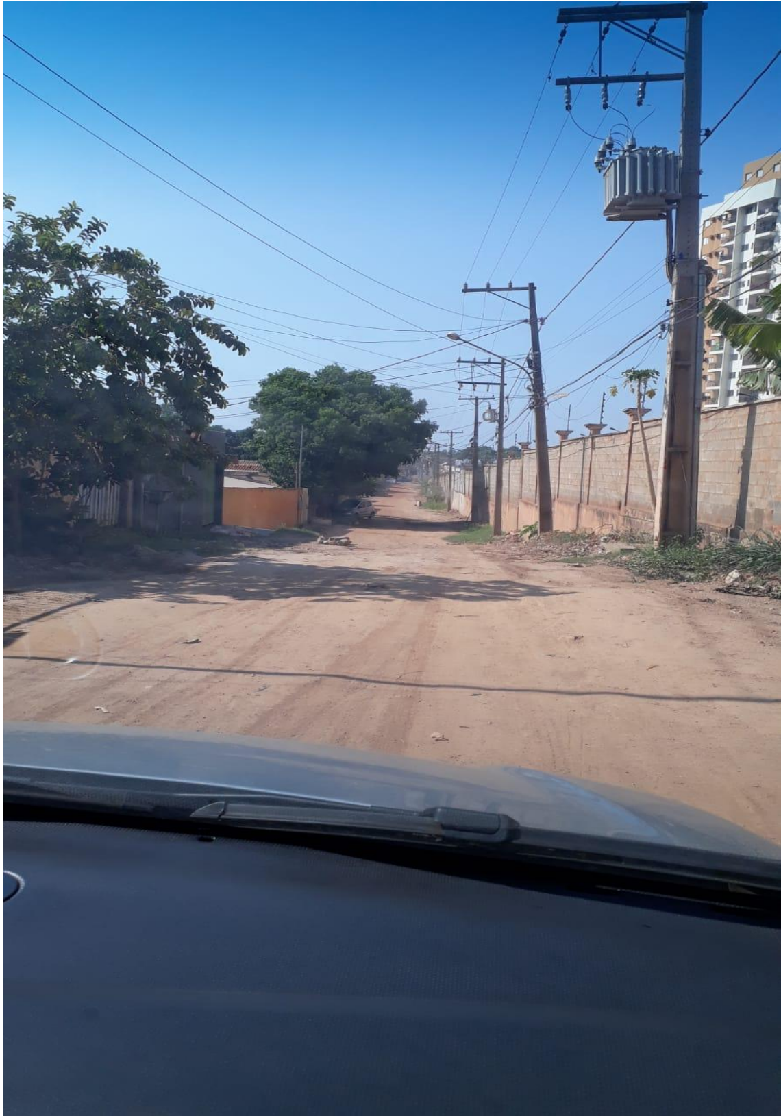
FOTO: PAVIMENTAÇÃO ASFÁLTICA RUA M QDRA 72 BAIRRO CENTRO AMERICA.
