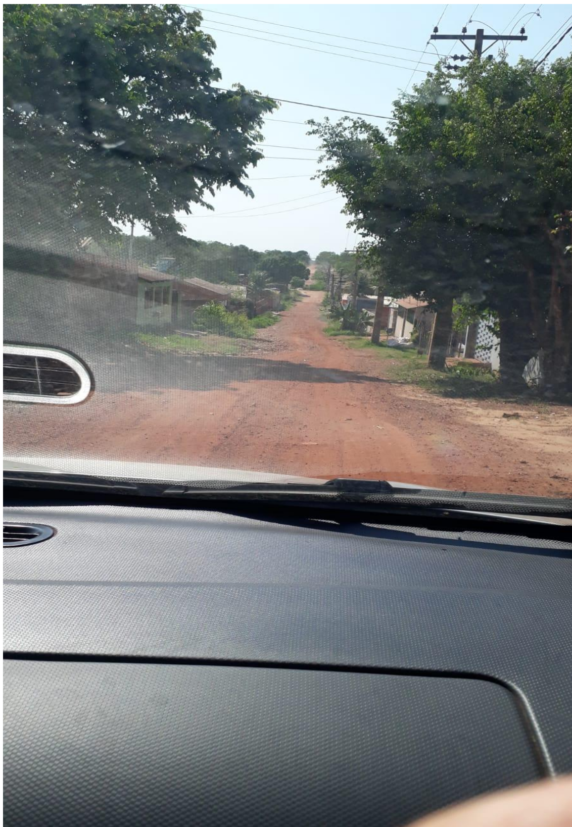
FOTO : PAV.ASFALTICA NA RUA DOS PENITENTES BAIRRO PLANALTO.
