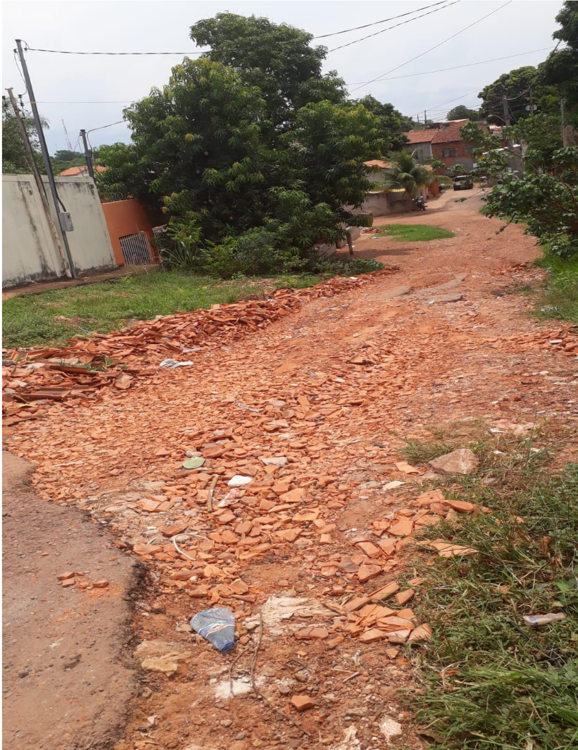
FOTO PAV. ASFALTICA NA RUA SANTO ANTÔNIO DO LEVERGER NO CPA 2.
