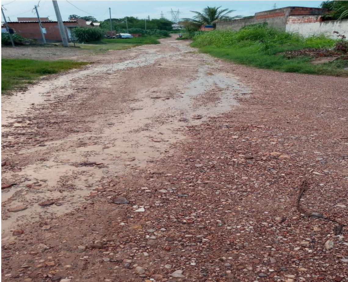
RUA 16 DO BAIRRO NOVO MILENIO.
