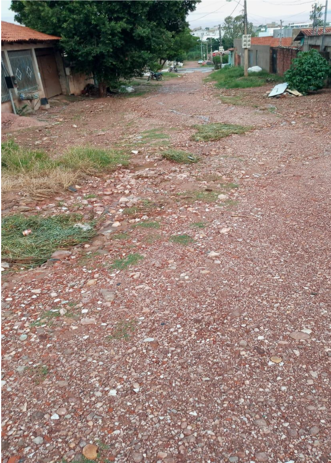
RUA 22 DO BAIRRO NOVO MILENIO.
