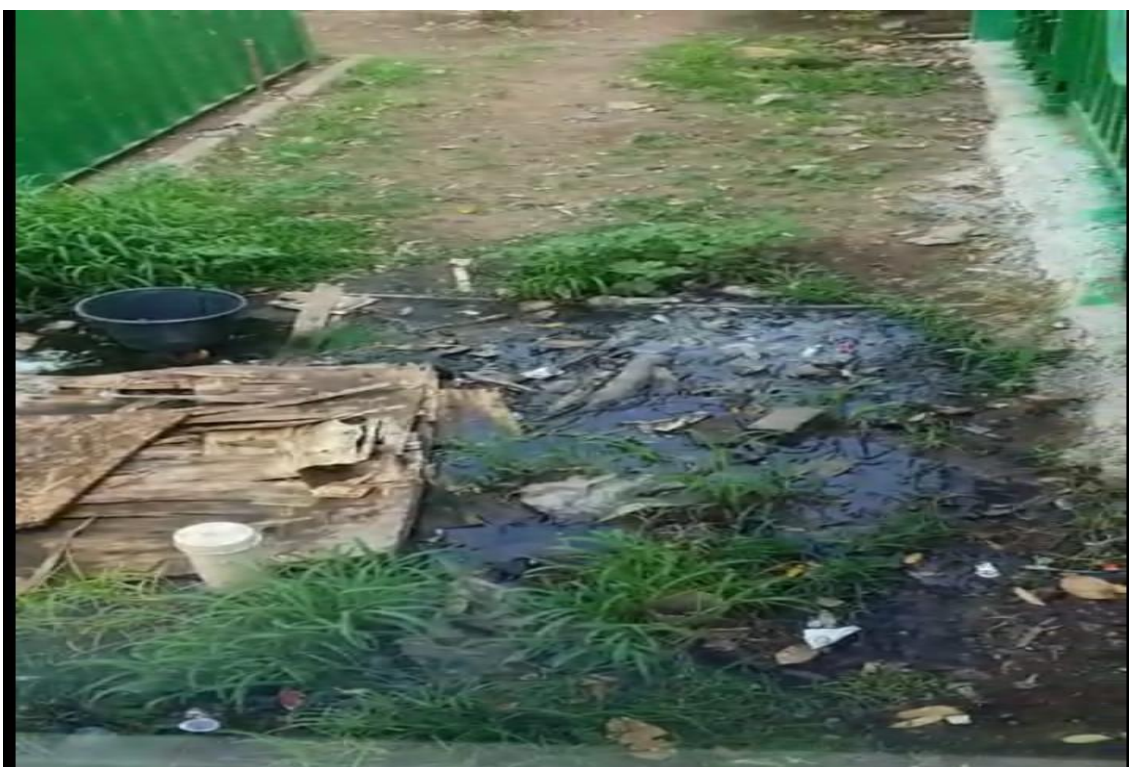
LIMPEZA DE BOCA DE LOBO OU ESGOTO NO BISPO DOM JOSE
