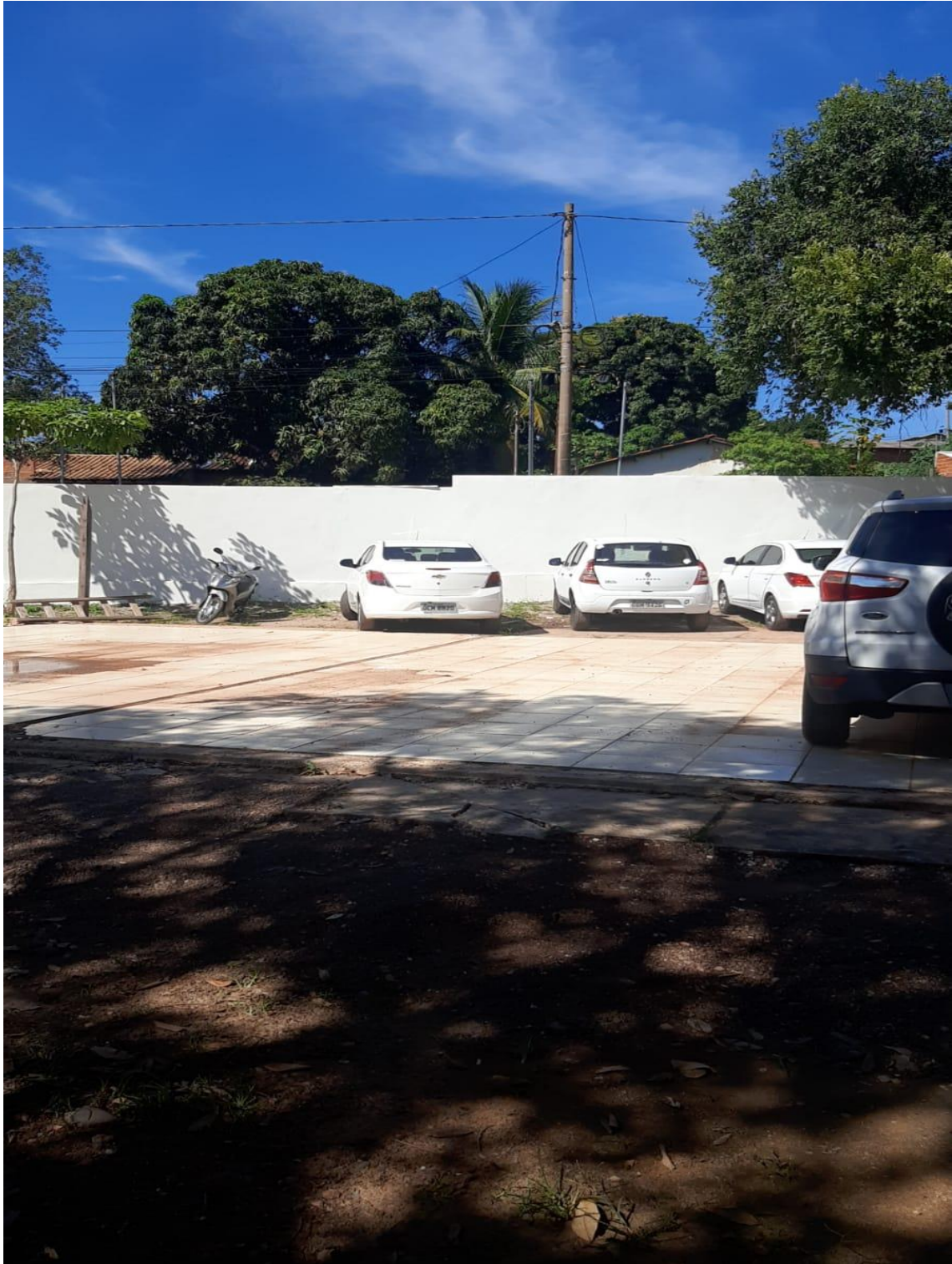
Construção de quadra na EMEB José torturou da silva no Bairro residencial coxipo
