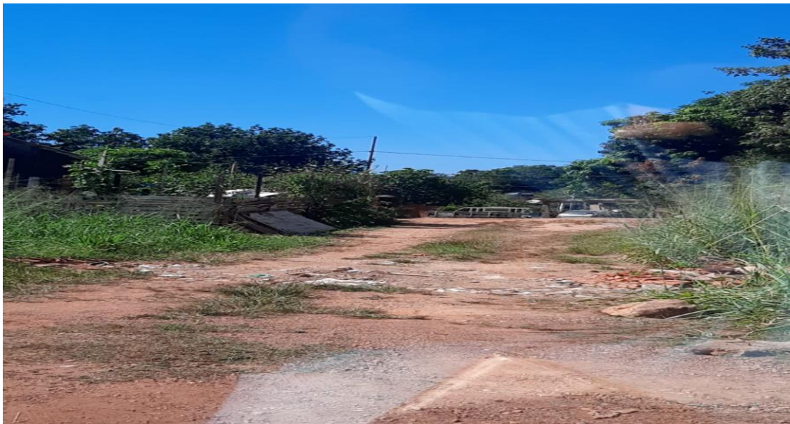
Foto 3 patrolamento e cascalhamento em toda extensão nas Ruas Marieta Campos com 23 no Bairro Jardim Florianópolis – Nesta Capital.
