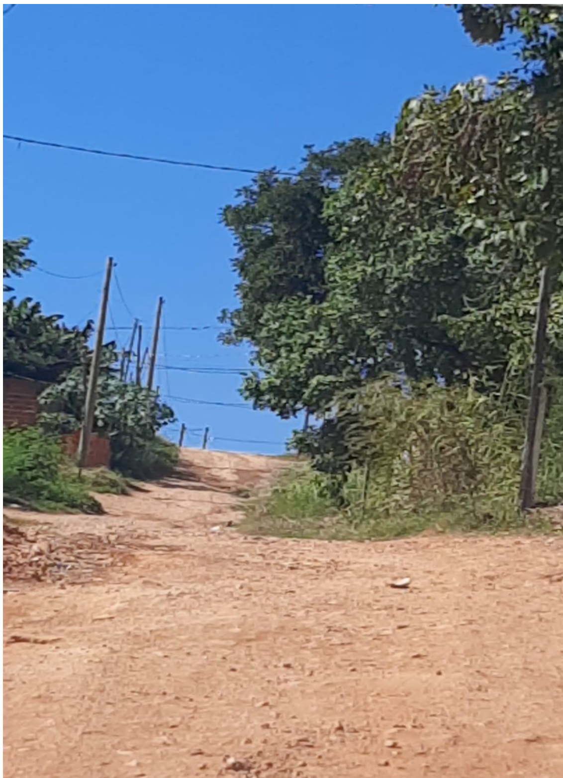
Foto 4 Patrolamento cascalhamento Rua 4 bairro Paraísopolis
