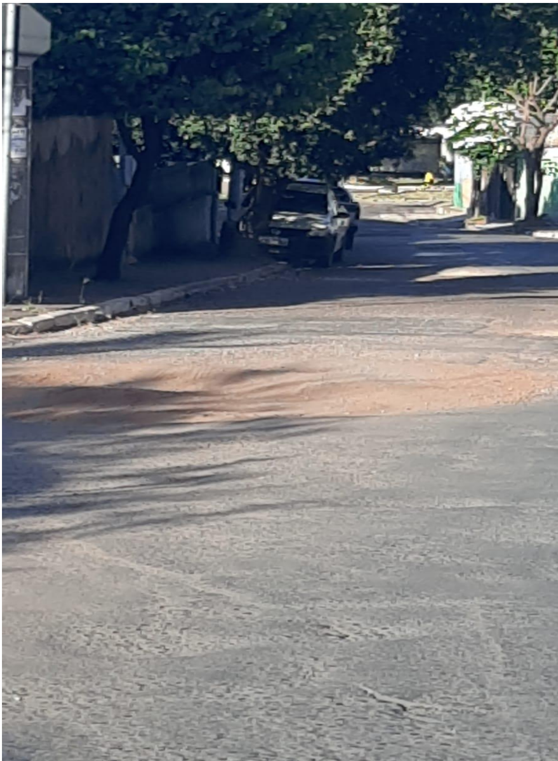
Serviço de tapa buracos na Rua Papa João 23, no Bairro Dom Aquino.
