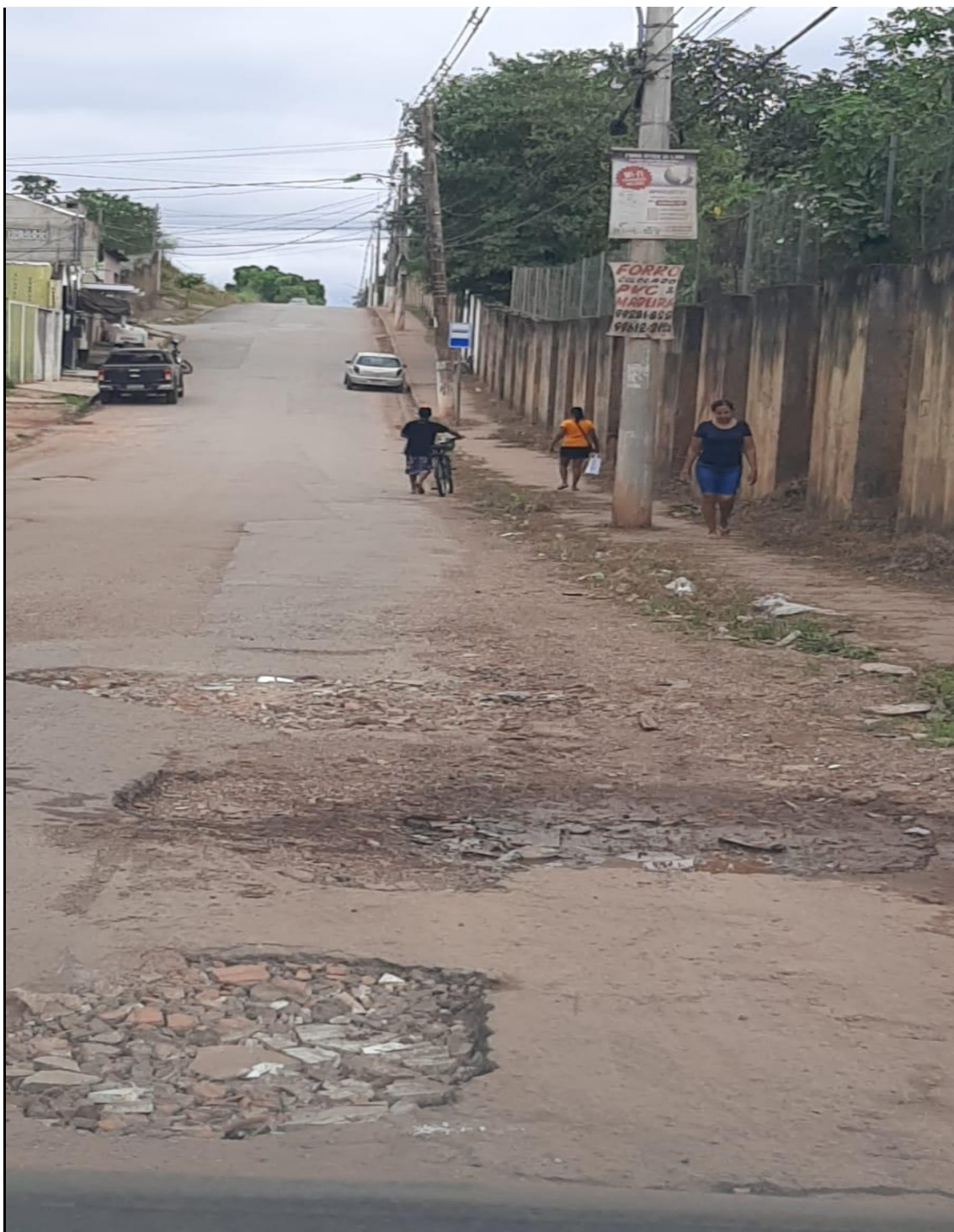
Tapa buracos Av. Crescencio Gregório de Almeida Bairro Novo colorado.
