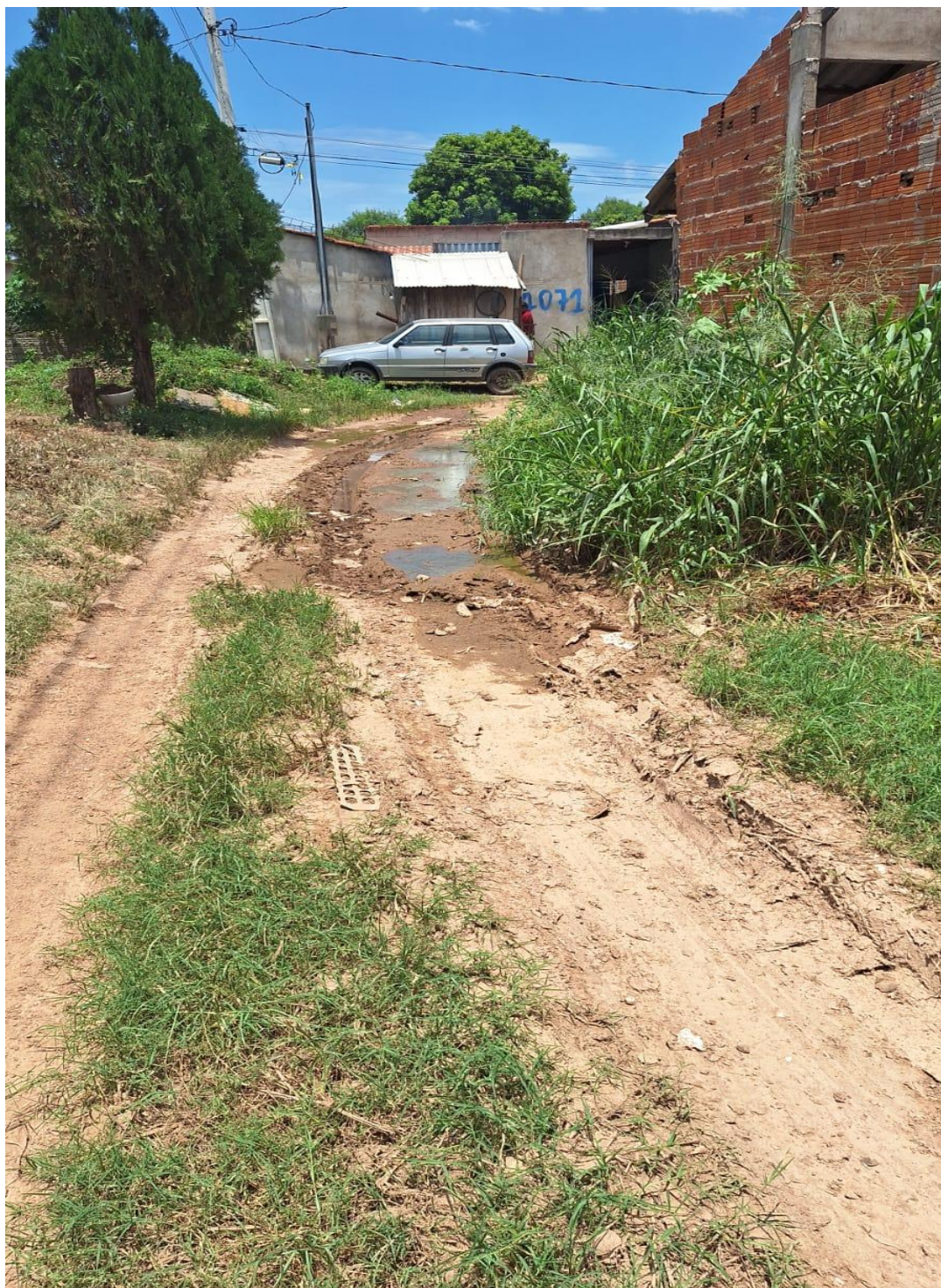
Serviço de encascalhamento e patrolamento na Av. Beira Rio ao lado da lanchonete Areão, no Bairro Jardim Santa Isabel.
