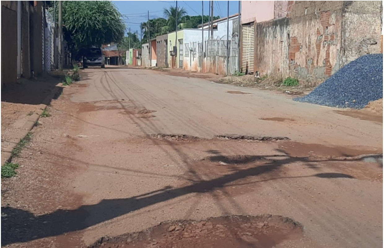
Tapa buracos na Rua 414 Bairro Tijucal Setor 4 recapeamento total.
