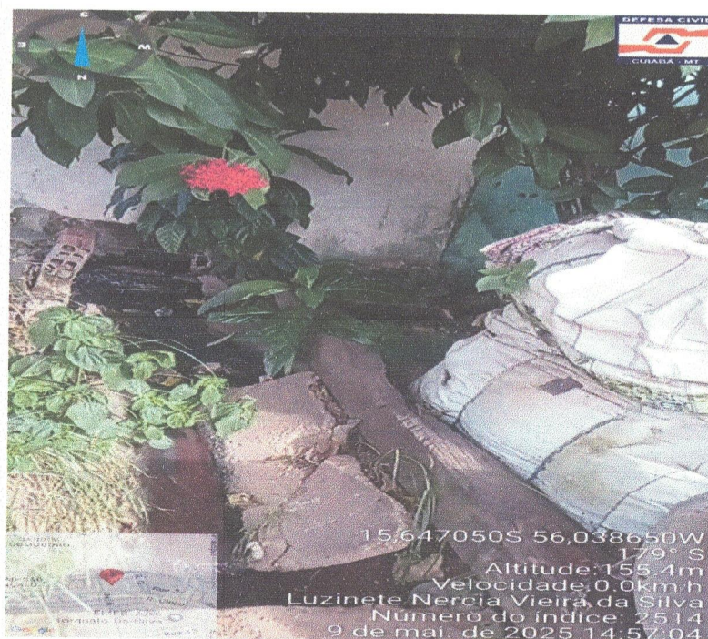
Figura 25. Saída do esgoto – Calçada da edificação
