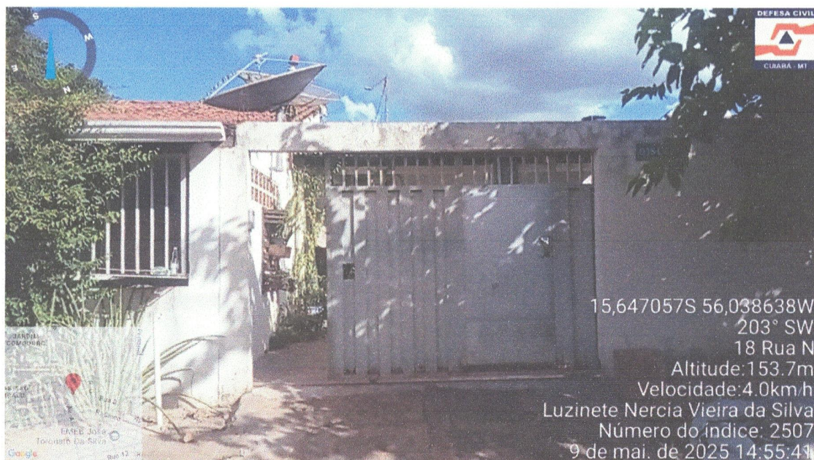
Figura 22. Fachada da residencia – Rua N, casa 02 Cohab São Gonçalo.
