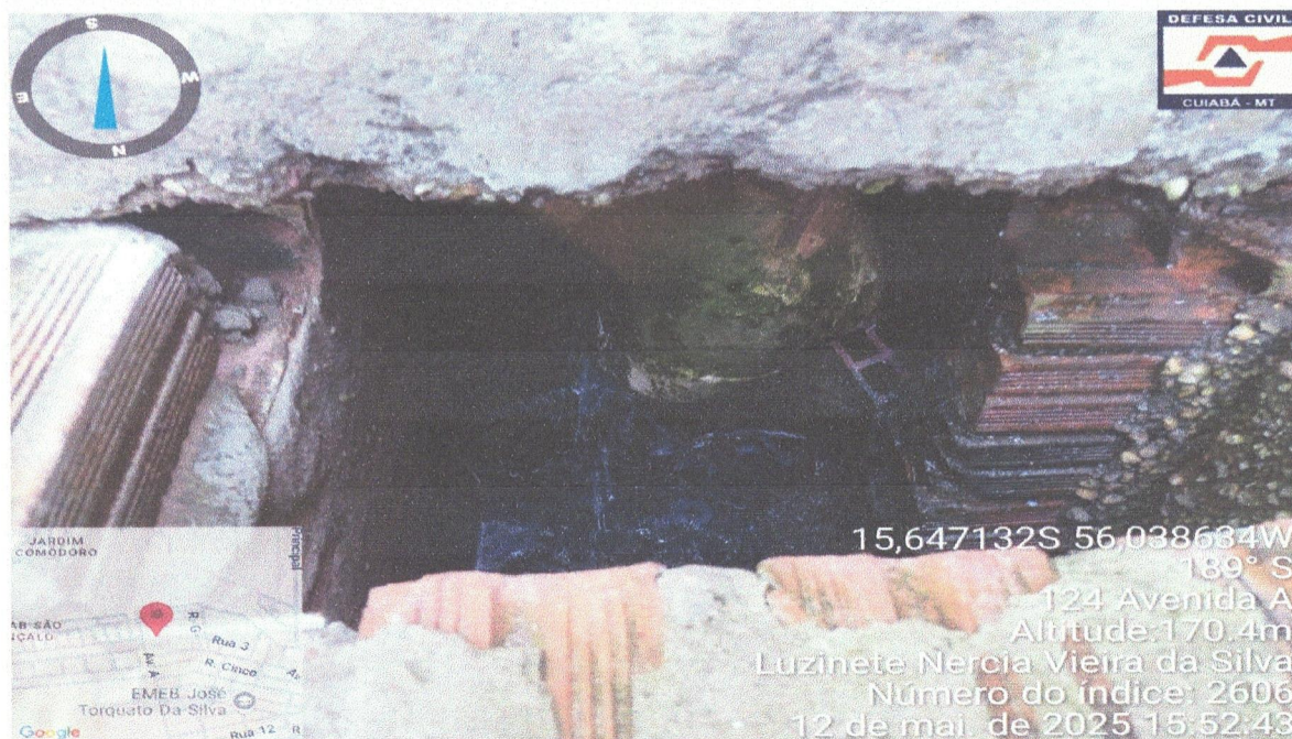
Figura 11. Caixa de entrada (muro dos fundos – Casa 2).
