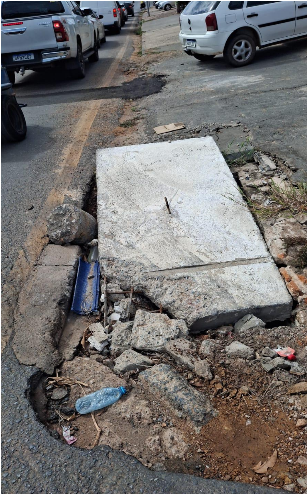
Manutenção de Boca de Lobo Rua General Mello esquina com a Rua Projetada F, no Bairro Campos Elízio
