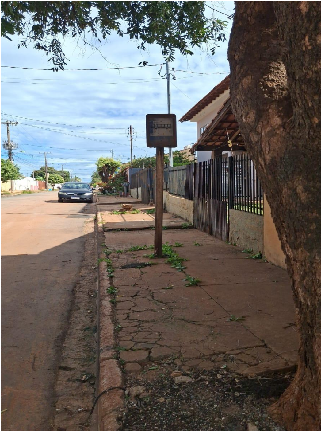
Construção e instalação de cobertura de ponto de ônibus na Rua Imburana no Bairro Jardim Gramado
