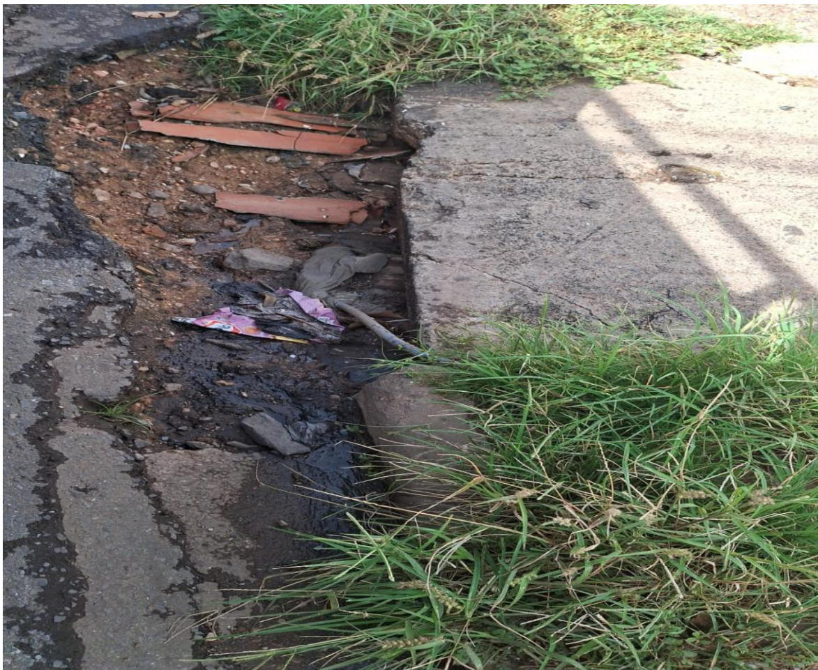
Manutenção e limpeza de Boca de Lobo e meio fio na Rua Paquetá no Bairro Praceiro
