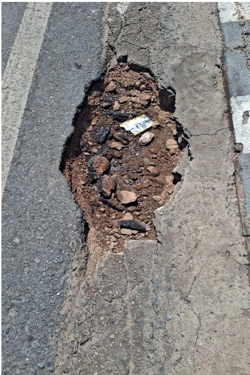
Serviço de tapa-buraco na Rua 19, localizada no bairro Altos do Coxipó
