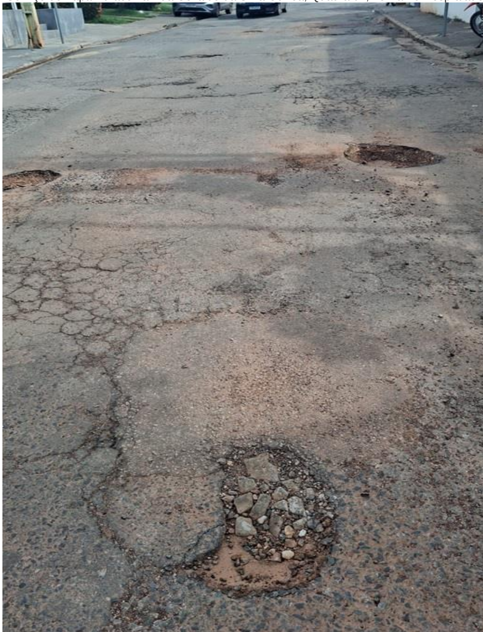
Serviço de Tapa Buraco na Rua Osvaldo da Silva Corrêa, Quadra 07, no Bairro Despraiado
