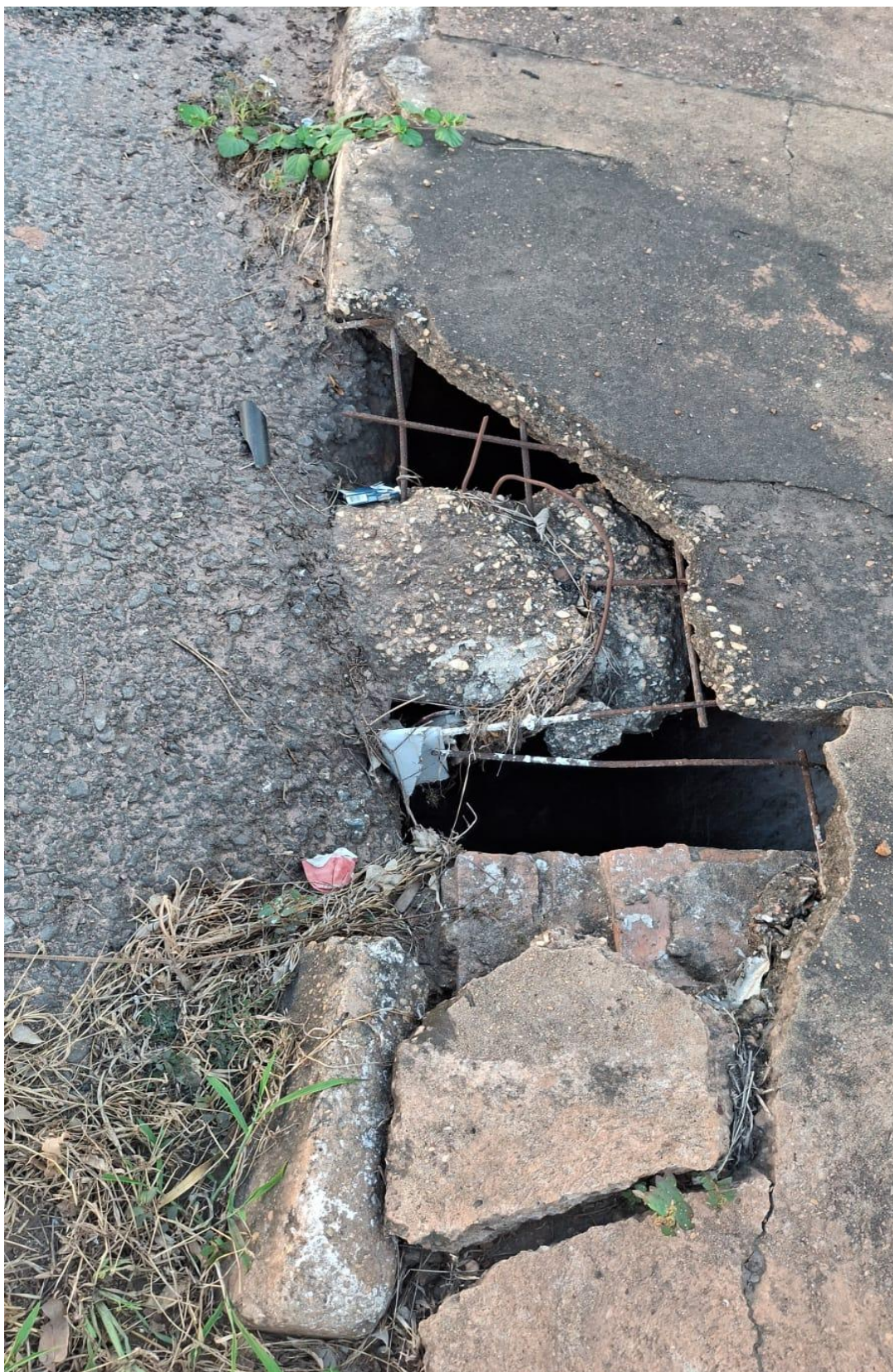
Serviço de Limpeza e Manutenção de Boca de Lobo na Rua dos Jaburus no Bairro Ohara
