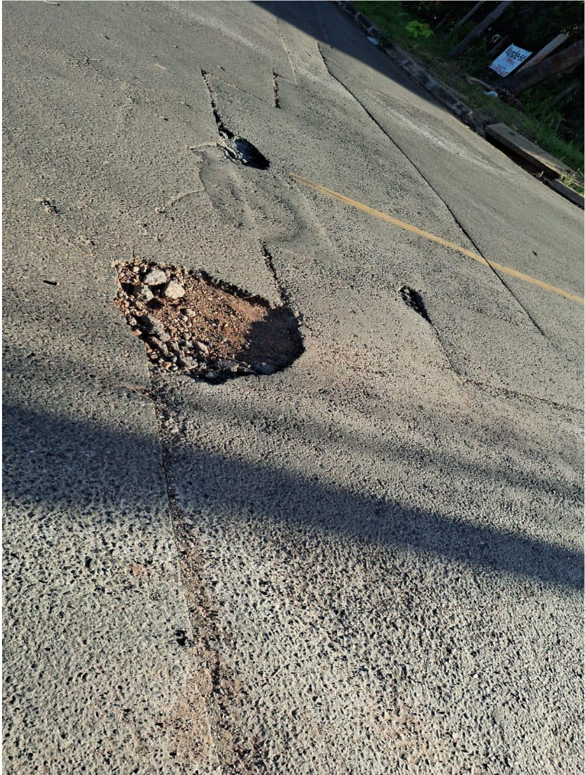
Serviço de Tapa Buraco na Rua dos Curiangos com a esquina da Rua dos Tamoios no Bairro Parque Ohara.
