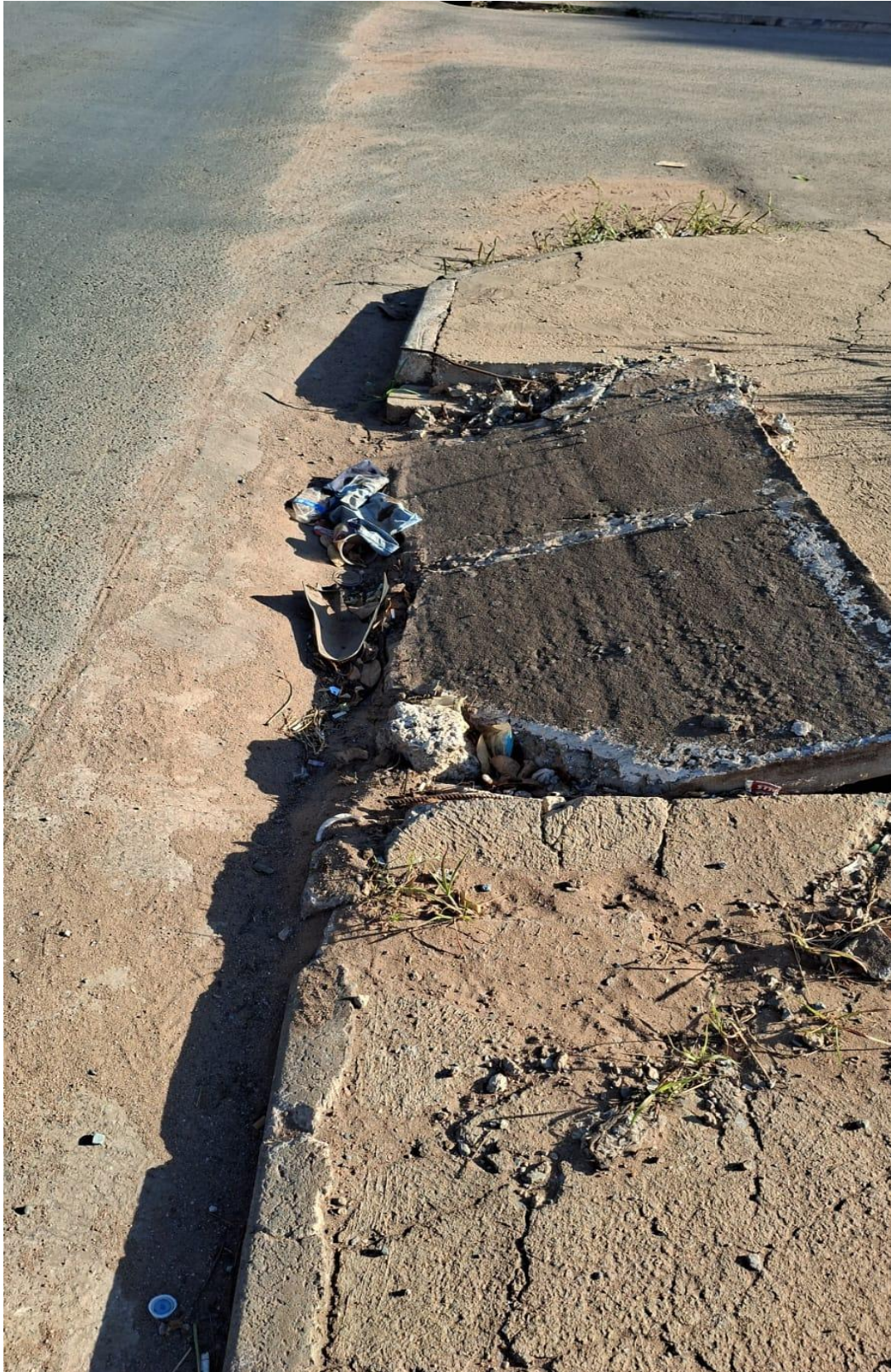
Serviço de limpeza e manutenção de boca de lobo na Rua das Araras, no Bairro Parque Ohara.
