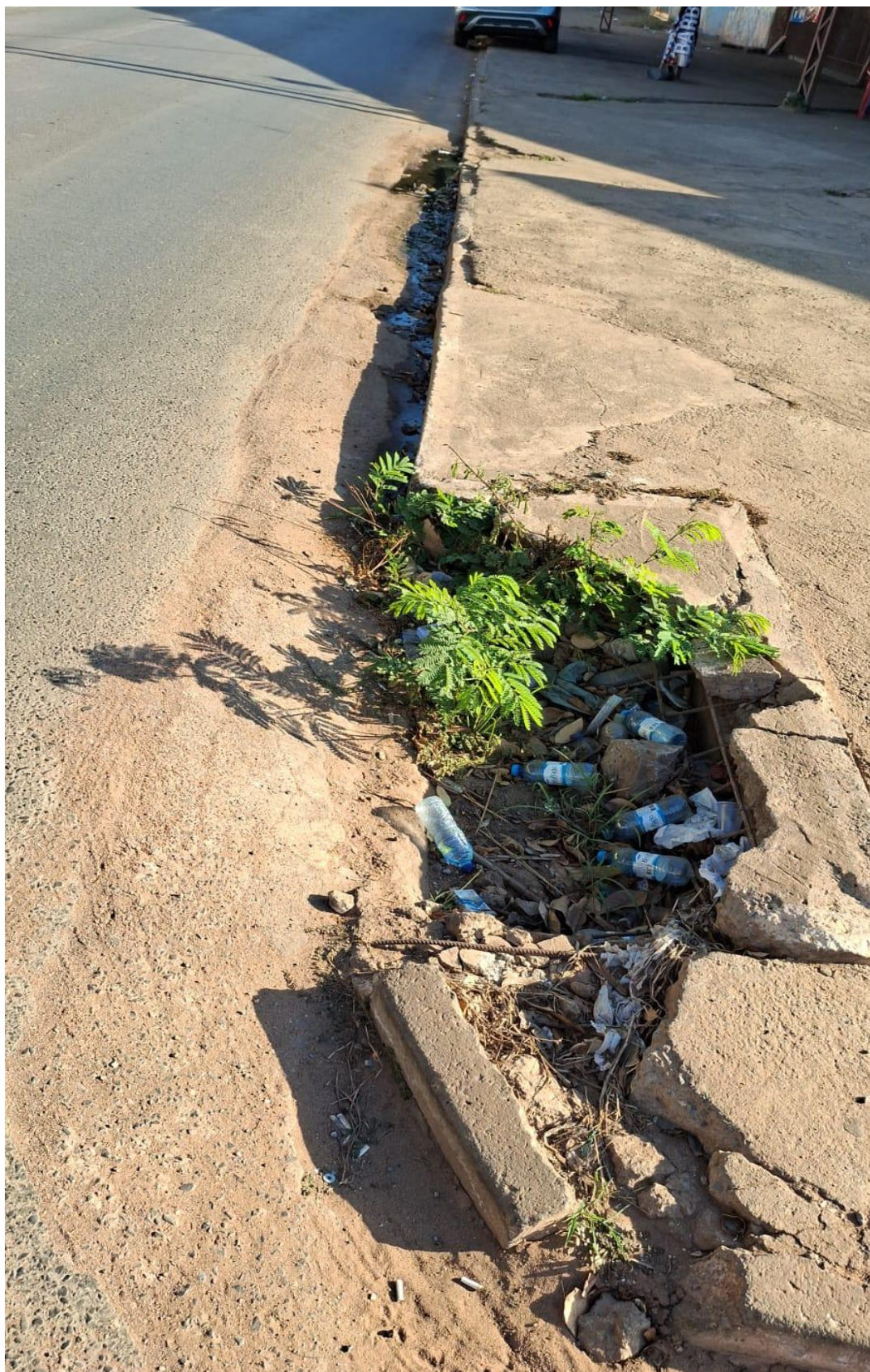
Serviço Boca de Lobo na Rua das Araras no Bairro Parque Ohara
