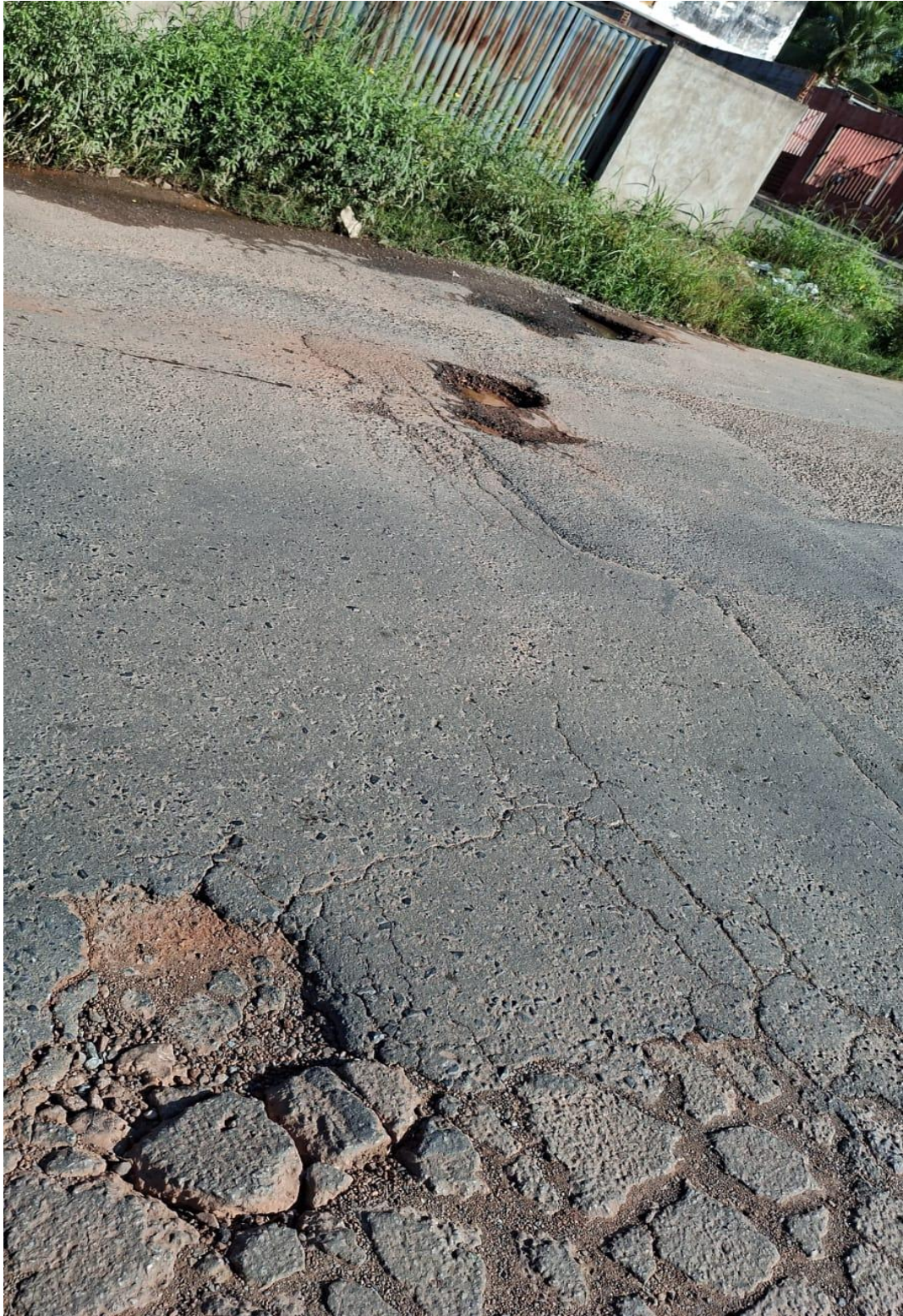
Serviço de Tapa Buraco na Avenida J, no Bairro Parque Atalaia.
