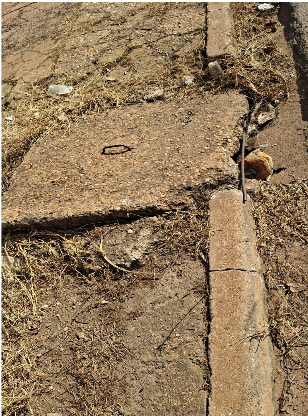
Serviço de Limpeza e Manutenção de Tamba de Boca de Lobo na Rua A, Quadra 11, no Bairro São Gonçalo.
