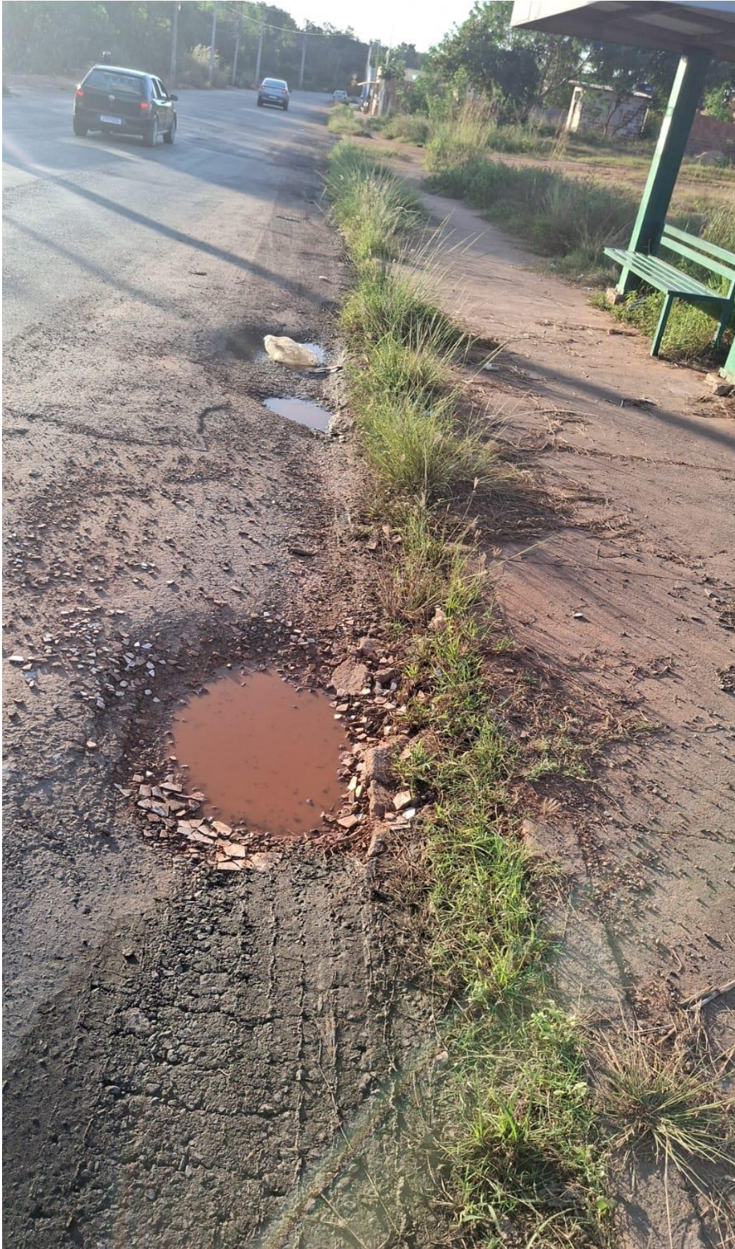
Serviço de tapa buracos na Avenida A, no Bairro Nova Canaã, 2ª Etapa.
