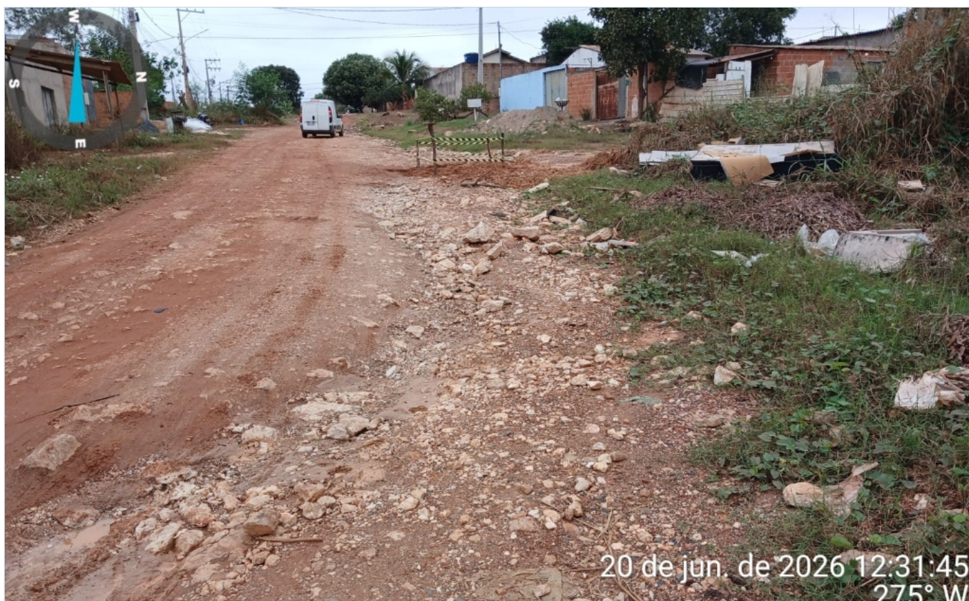
Vista longitudinal demonstrando irregularidades severas no leito trafegável.
