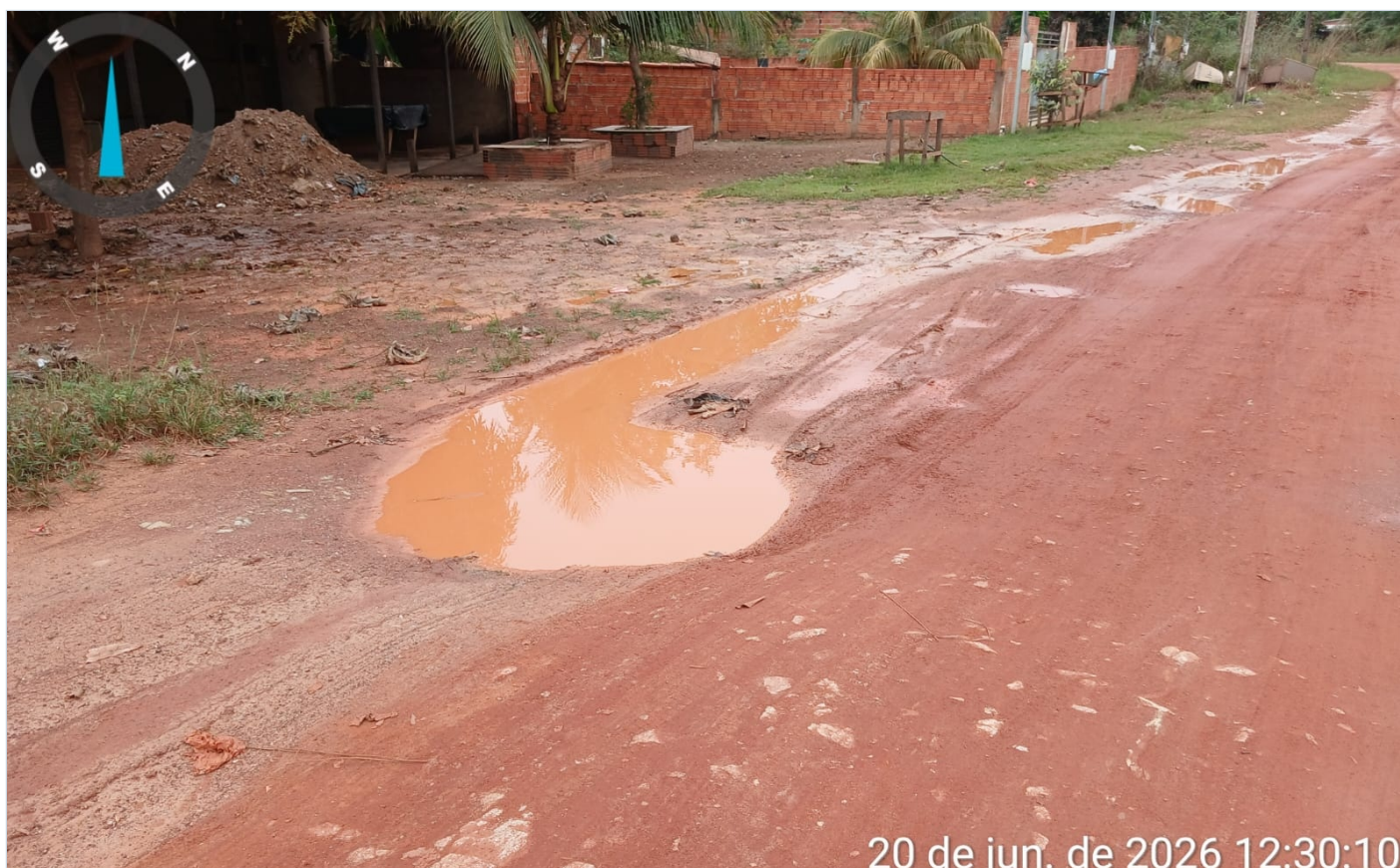
Ponto com acúmulo de água pluvial e lamaçal, prejudicando a mobilidade.
