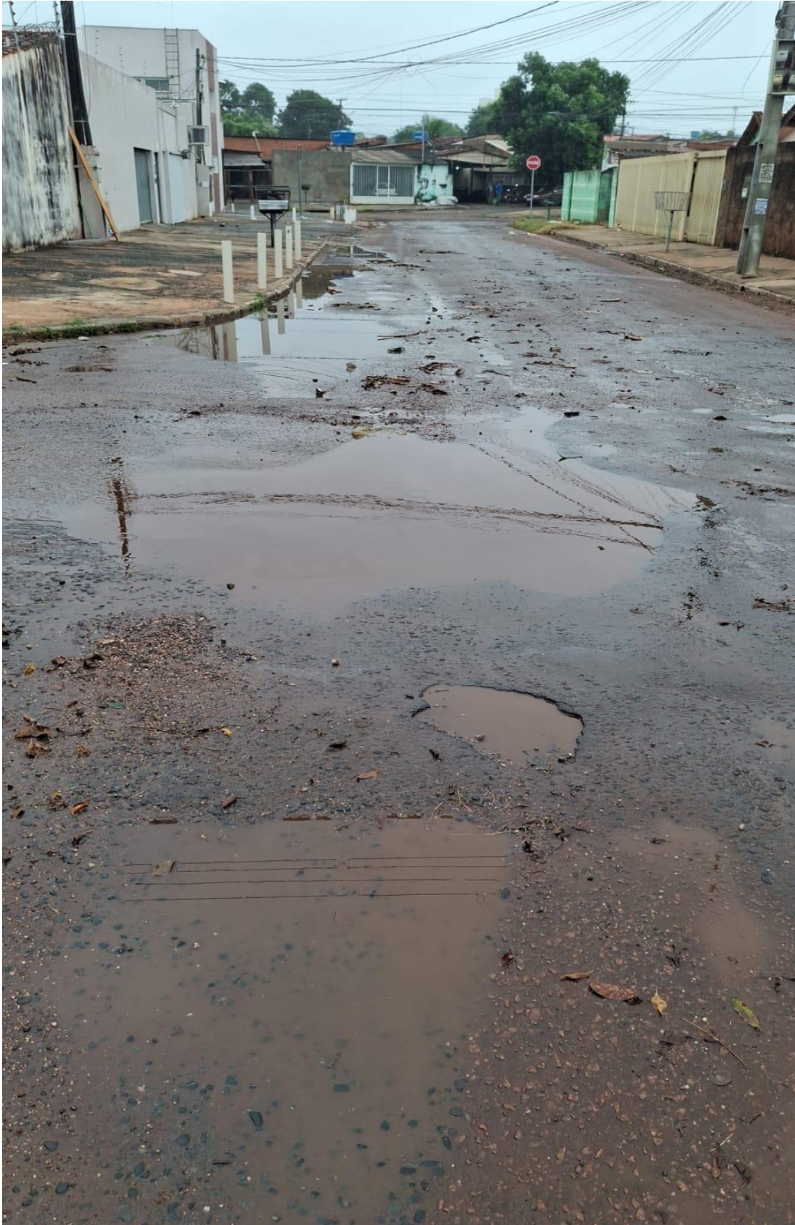
Serviço de tapa buracos na Rua Anastácio, no Bairro Jardim Ubatã.
