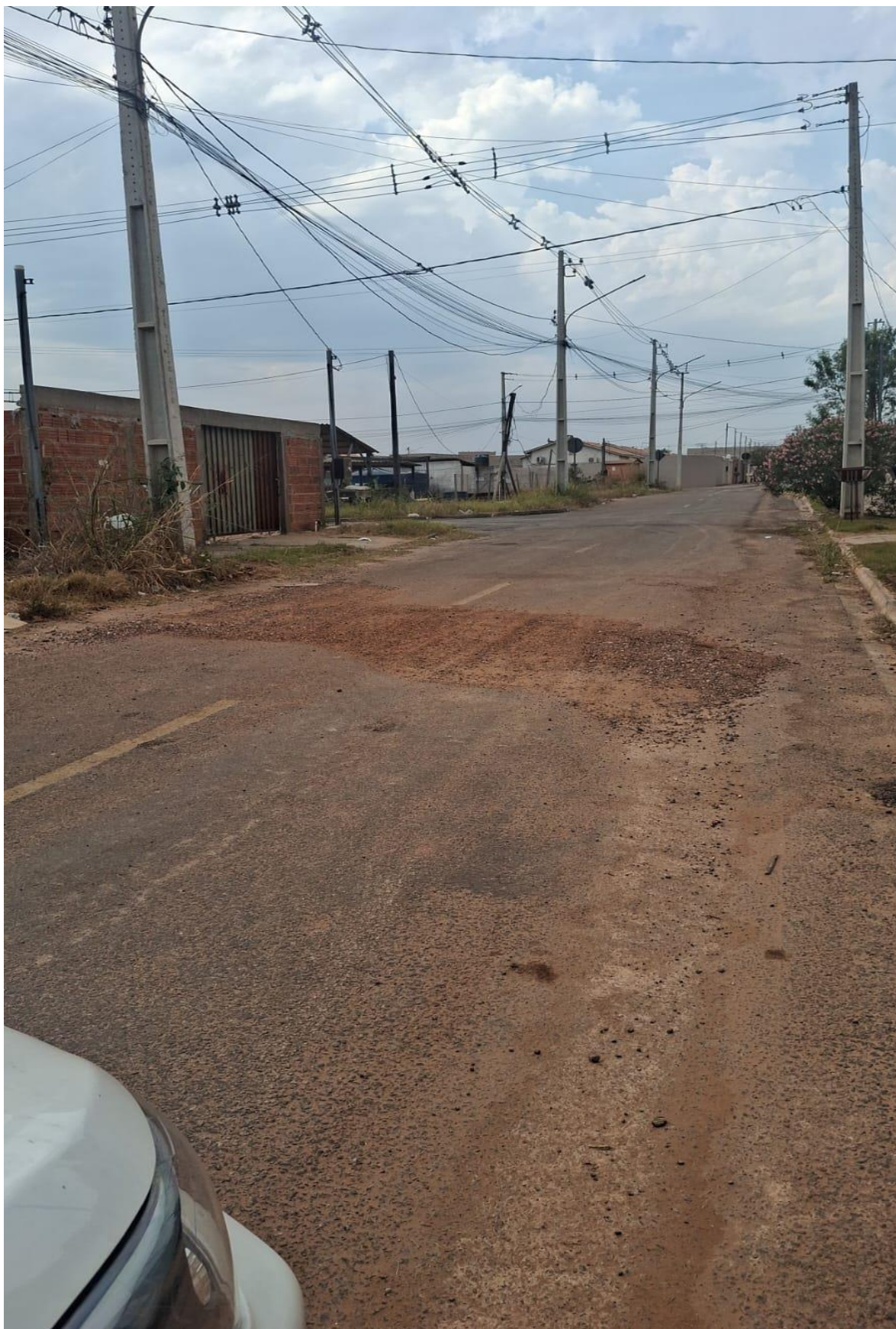
Serviço de tapa buraco na Rua 02, bairro Residencial Novo Tempo.
