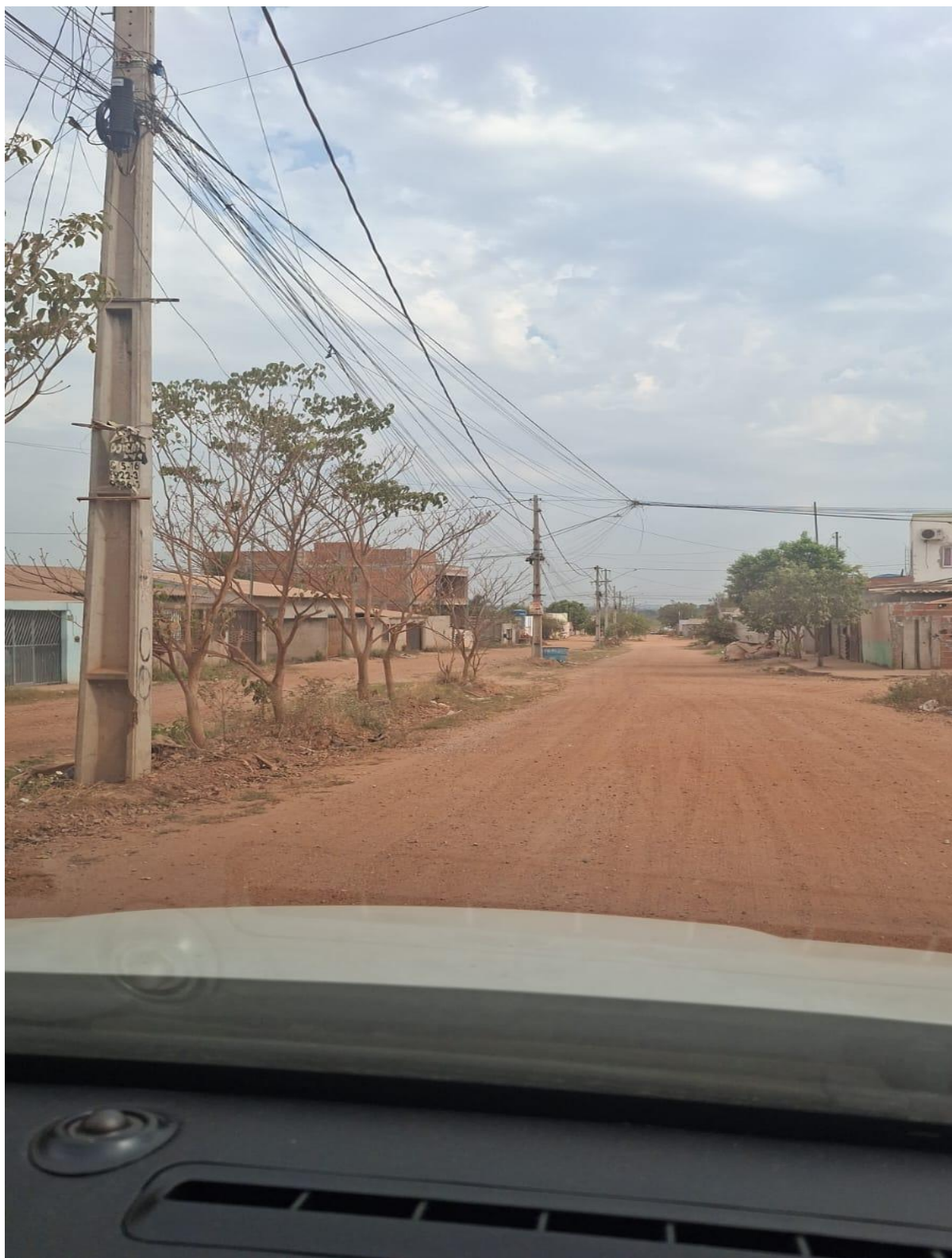
Serviço de malha asfáltica na Avenida Principal Floresta, no bairro Parque Mariana.
