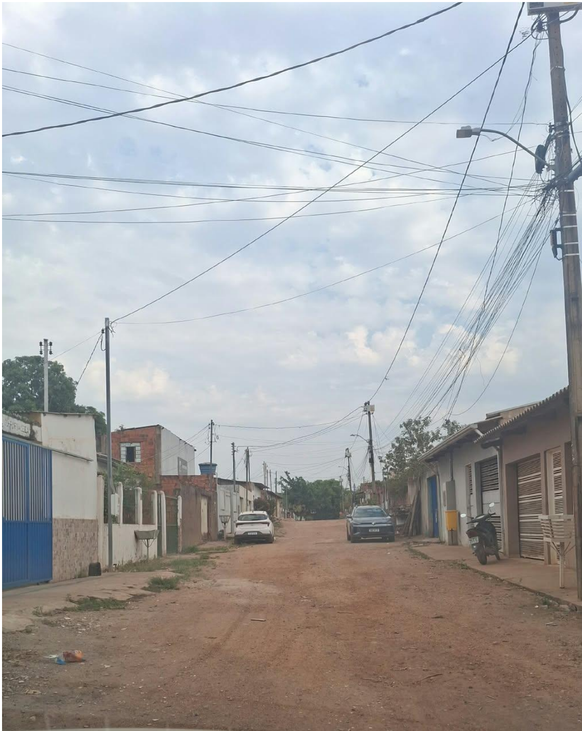
Serviço de malha asfáltica na Rua 05, no bairro Jardim Fortaleza.
