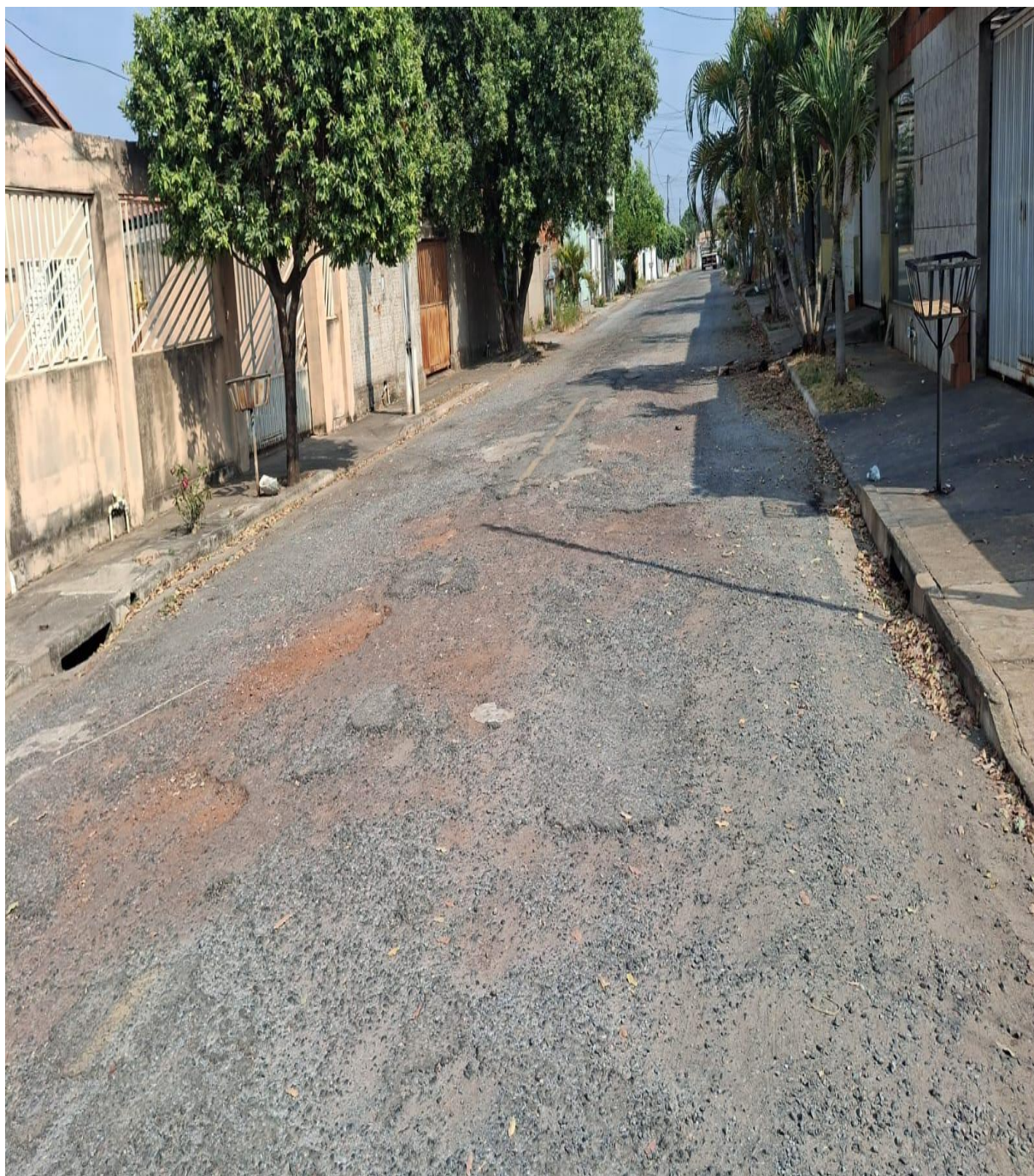
Serviço de recapeamento de malha asfáltica na Rua 08, Quadra 08, Residencial Aricá, no bairro Santa Laura.
