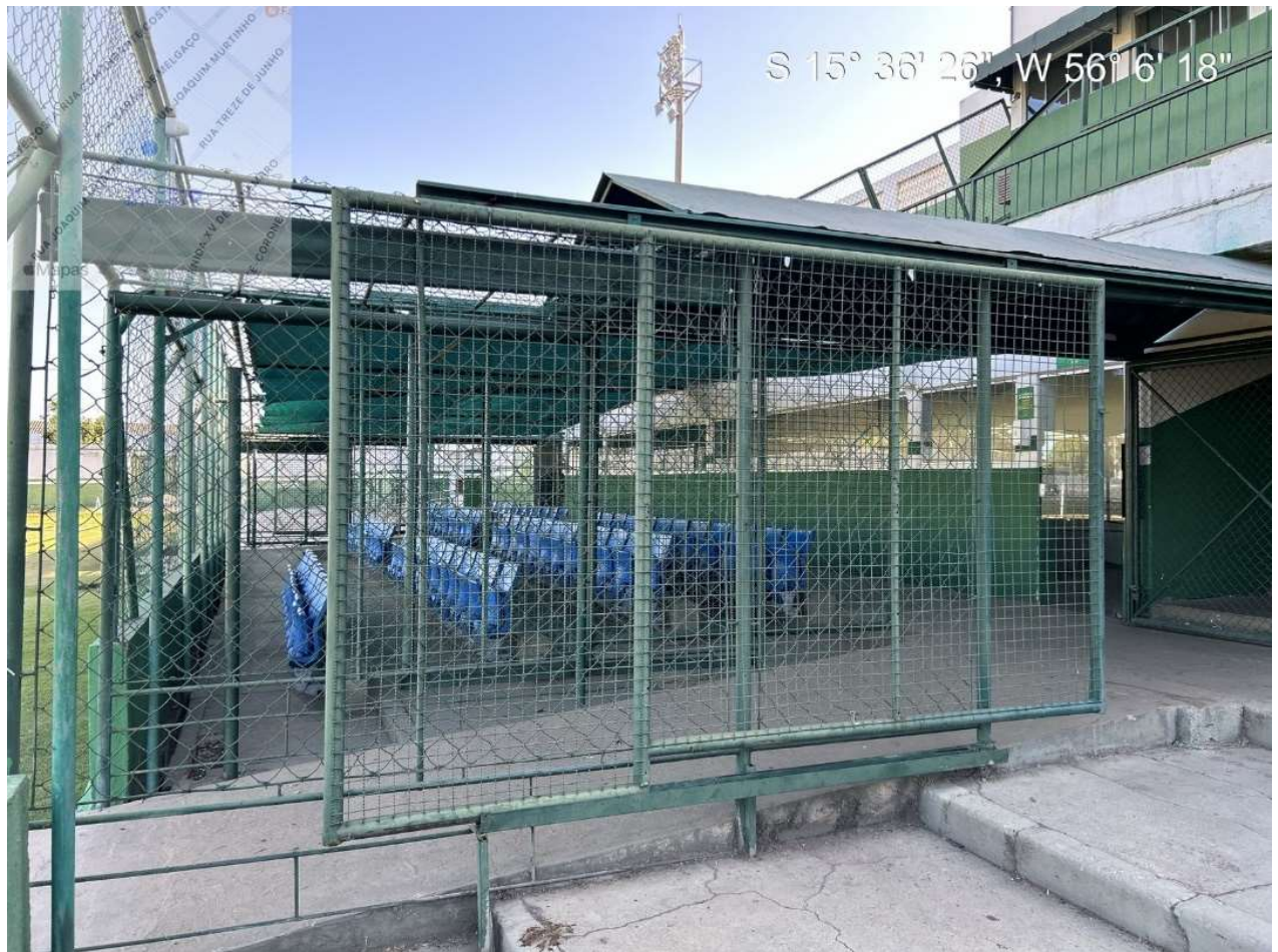
Figura 20: Situação da unidade
