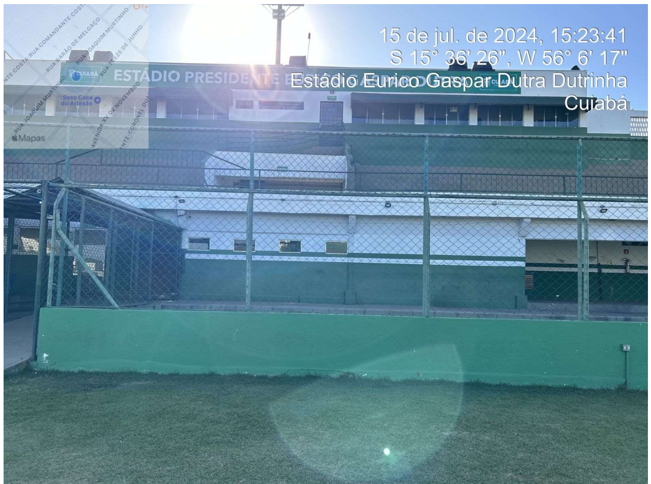
Figura 16: Situação da unidade
