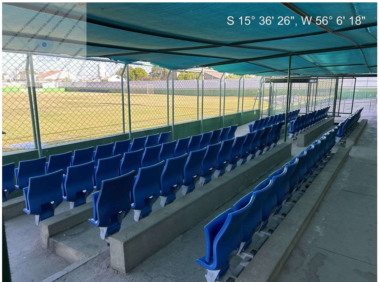
Figura 19: Situação da unidade
