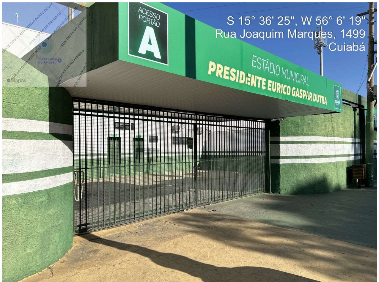
Figura 15: Situação da unidade
