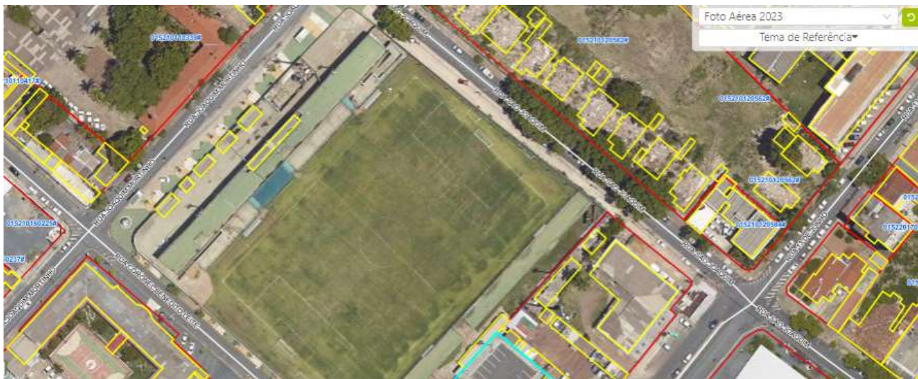
Figura 11: Situação da unidade
