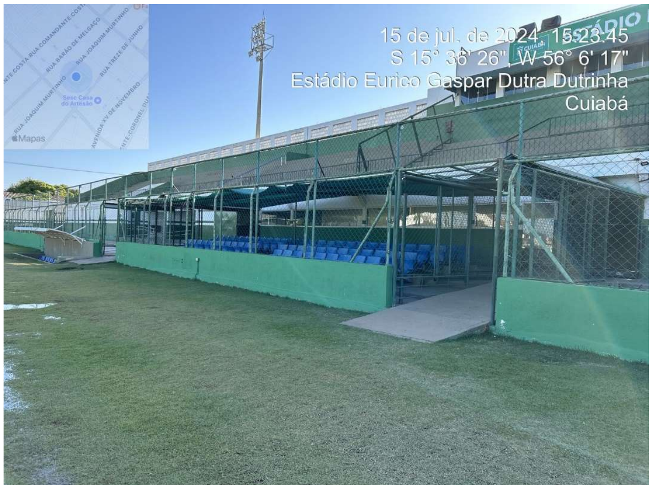
Figura 17: Situação da unidade
