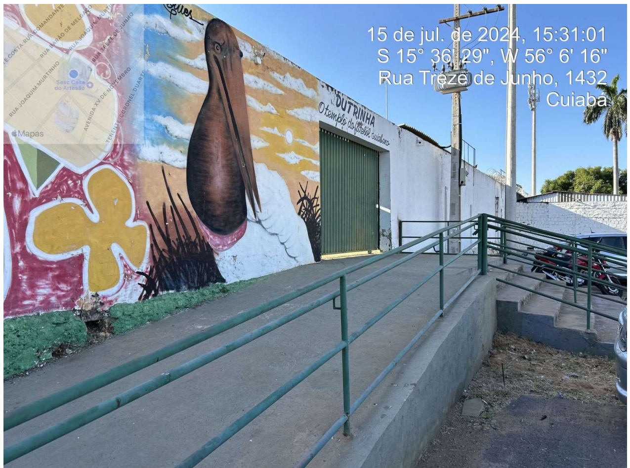
Figura 21: Situação da unidade
